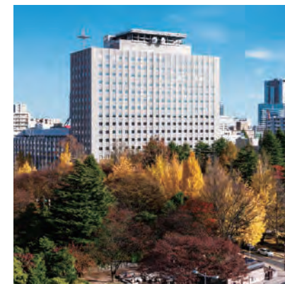
宮城県 | 2015年竣工
