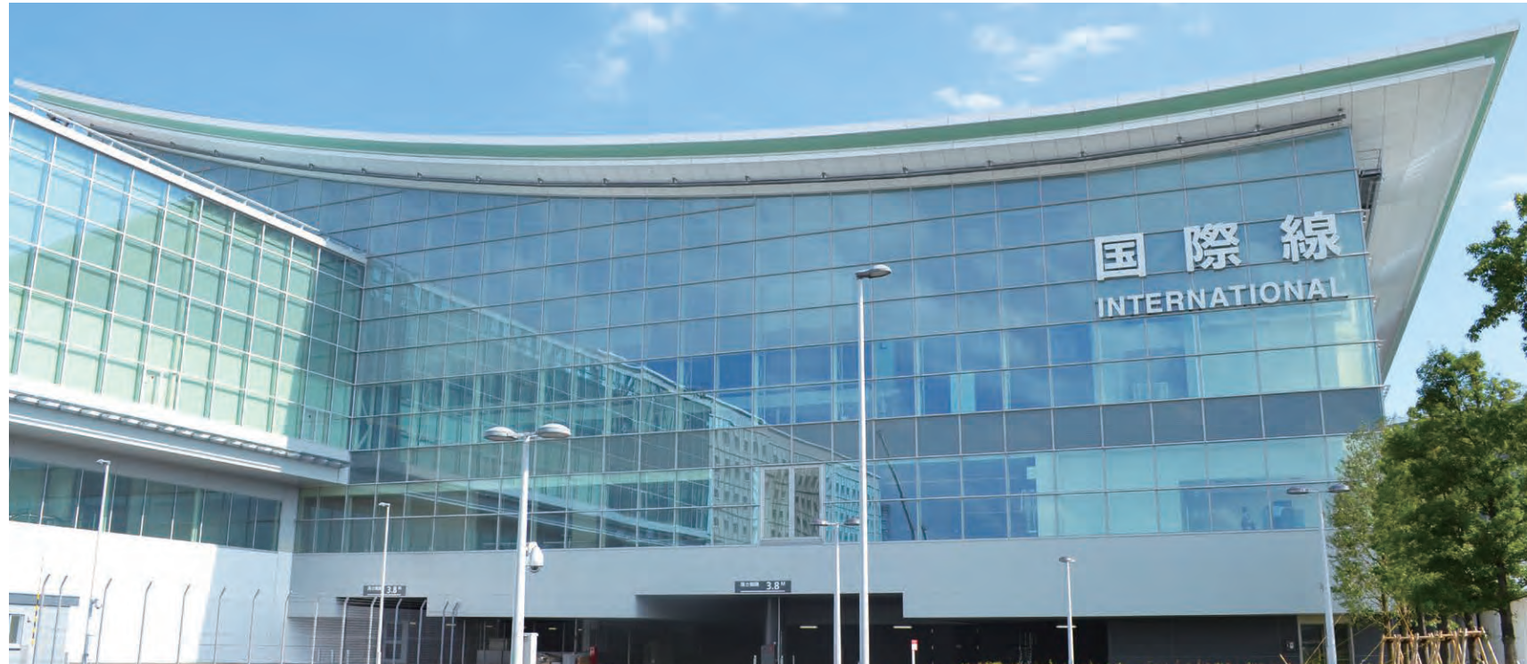
東京都 | 2014年増築・竣工
