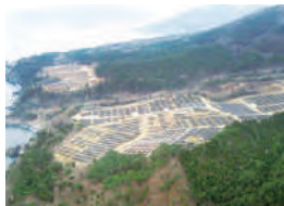
宮城県 | 2012年竣工
