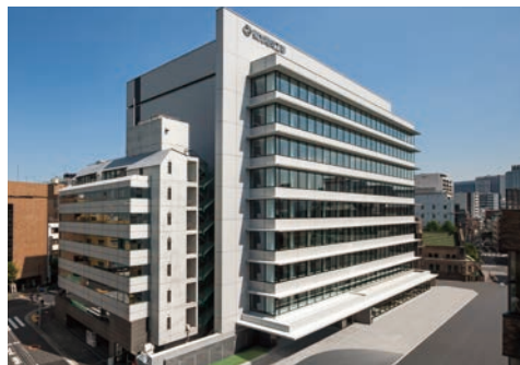
東光電気工事ビル
