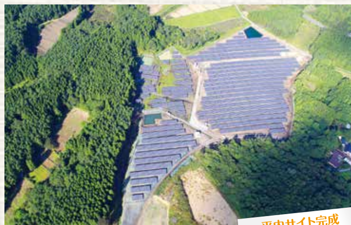
角浜サイト完成
