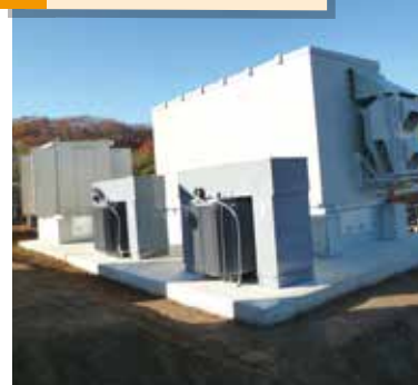
14 PCS+500kVA昇圧変圧器
