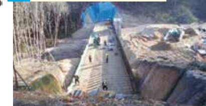
4 調整池 施工中
