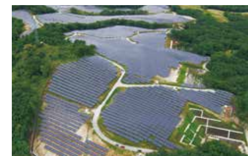
地形を活かした極力造成しない太陽光発電所
